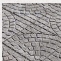
Pavimentazione in Cemento
